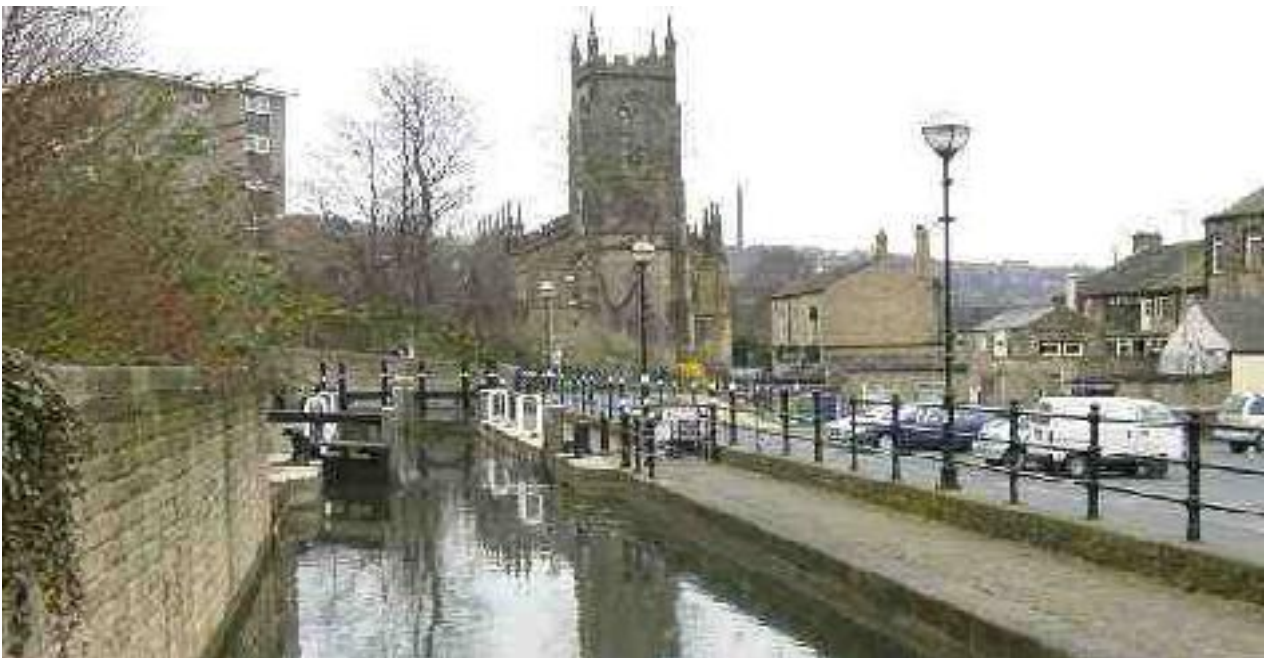
Tuel Lane Lock Sowerby Bridge.
